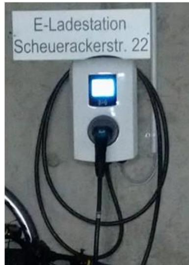
**Beispiel Beschriftung E-Ladestation in Tiefgarage mit mehreren Netzanschlüssen**
