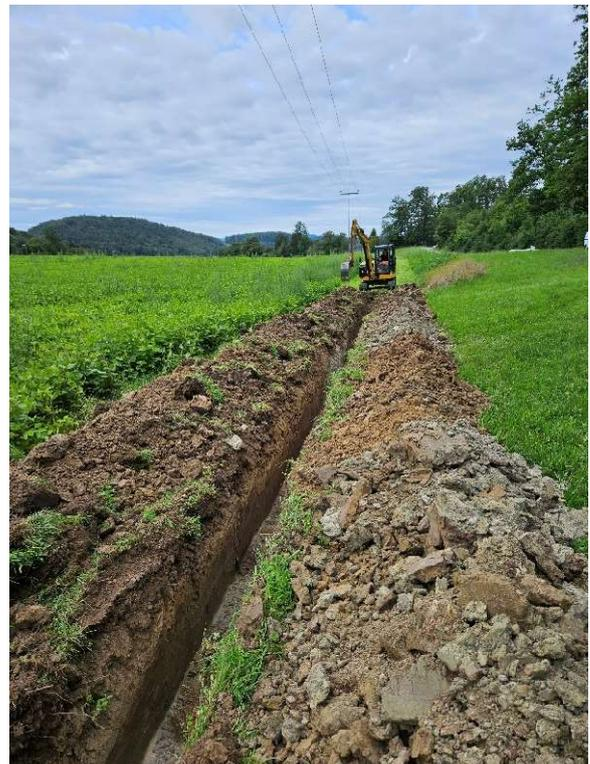
Verlegung Kabelschutzrohre und betonieren eines Unterflurschachtes:
