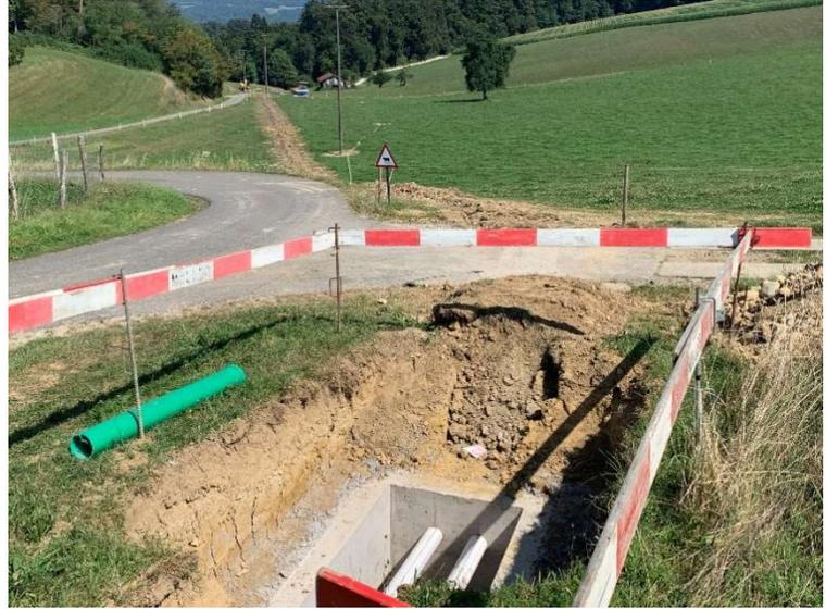
Einzug des Dreileiter-Kabelsystem sowie eines LWL-Schlauches für die Kommunikation im November 2023
