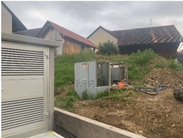
Abbau der alten Station
