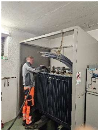
Vorbereitung des alten Trafos zur Demontage
