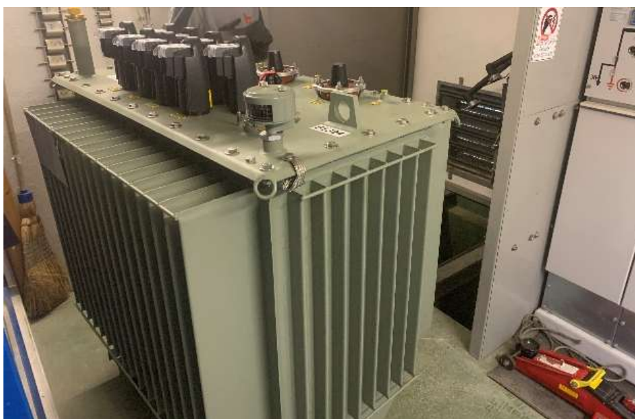
Bereit zum Einbau in die Trafonische
