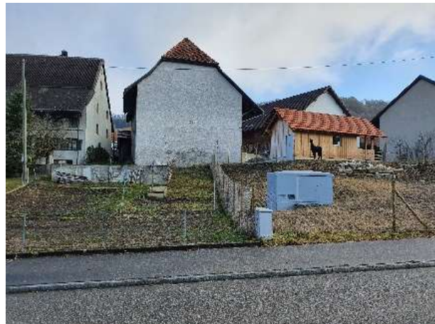
Die alte Station mitten in der Parzelle
