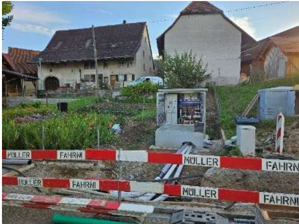
Anschliessen der neuen Station sowie der sichtbare massive Rohrblock
