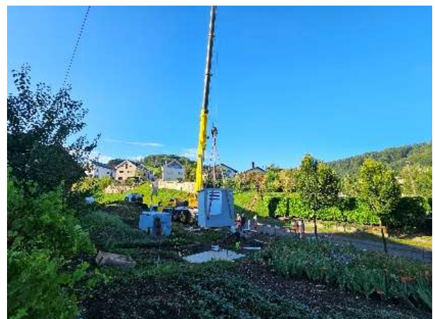
Anlieferung und versetzen der neuen Station
