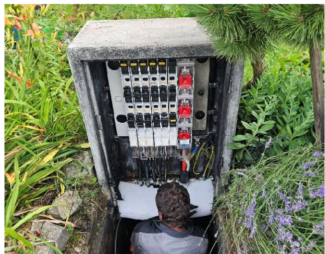
Gereinigte sowie neu bestückte Verteilkabine
