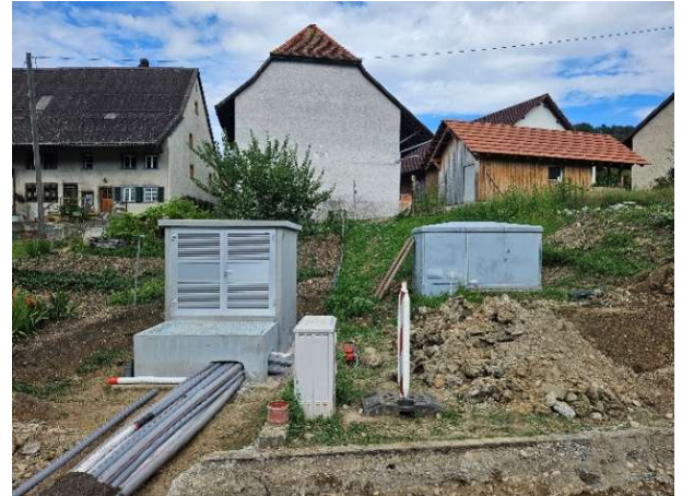
Anschliessen der neuen Station sowie der sichtbare massive Rohrblock
