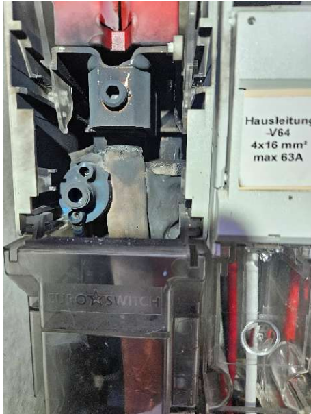
Kurzschluss an der Einspeisesiche- rungsleiste
