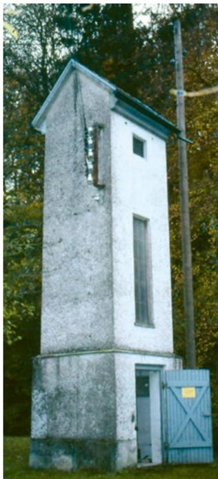
Alte Turmstation, erbaut 1925/26 mit einer Grundfläche (innen) von 1,6 m x 1,8 m und zwei Zwischenböden.
