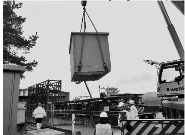
Ein neuer Kabelvorschacht wurde eingebaut. Auf das neue Fundament konnte im November eine Fertigbetonstation aufgesetzt werden.
