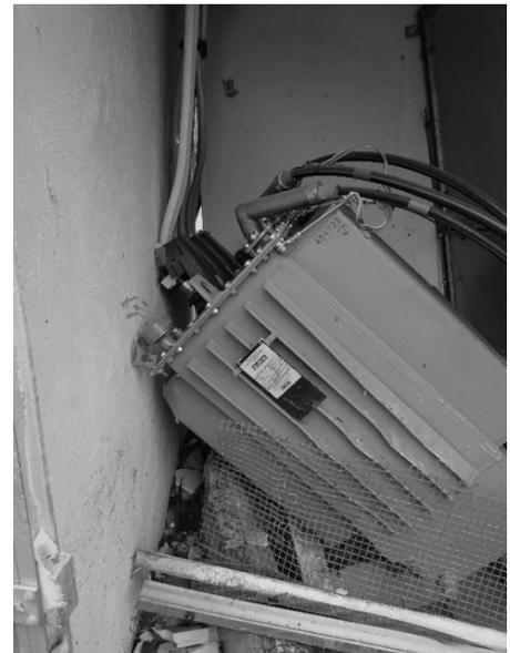
Der Transformator wurde in der Trafobox ca. 1m nach hinten und von den Laufschiene geschoben.
