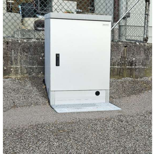
Erstellen einer neuen Verteilkabine an der Hauptstrasse
