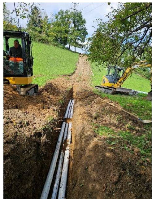
Grabarbeiten und Verlegung der Kabelschutzrohre
