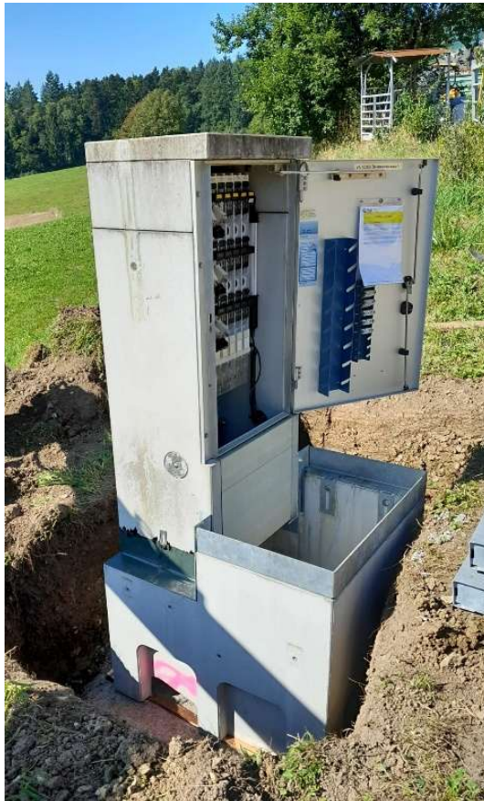
Erstellen einer neuen Verteilkabine an der Däielmattstrasse
