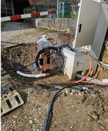
Erstellen einer neuen Verteilkabine an der Hauptstrasse
