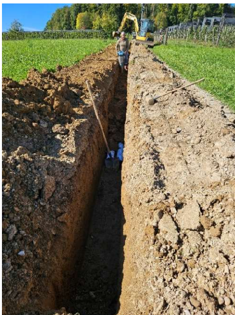
Grabarbeiten und Verlegung der Kabelschutzrohre
